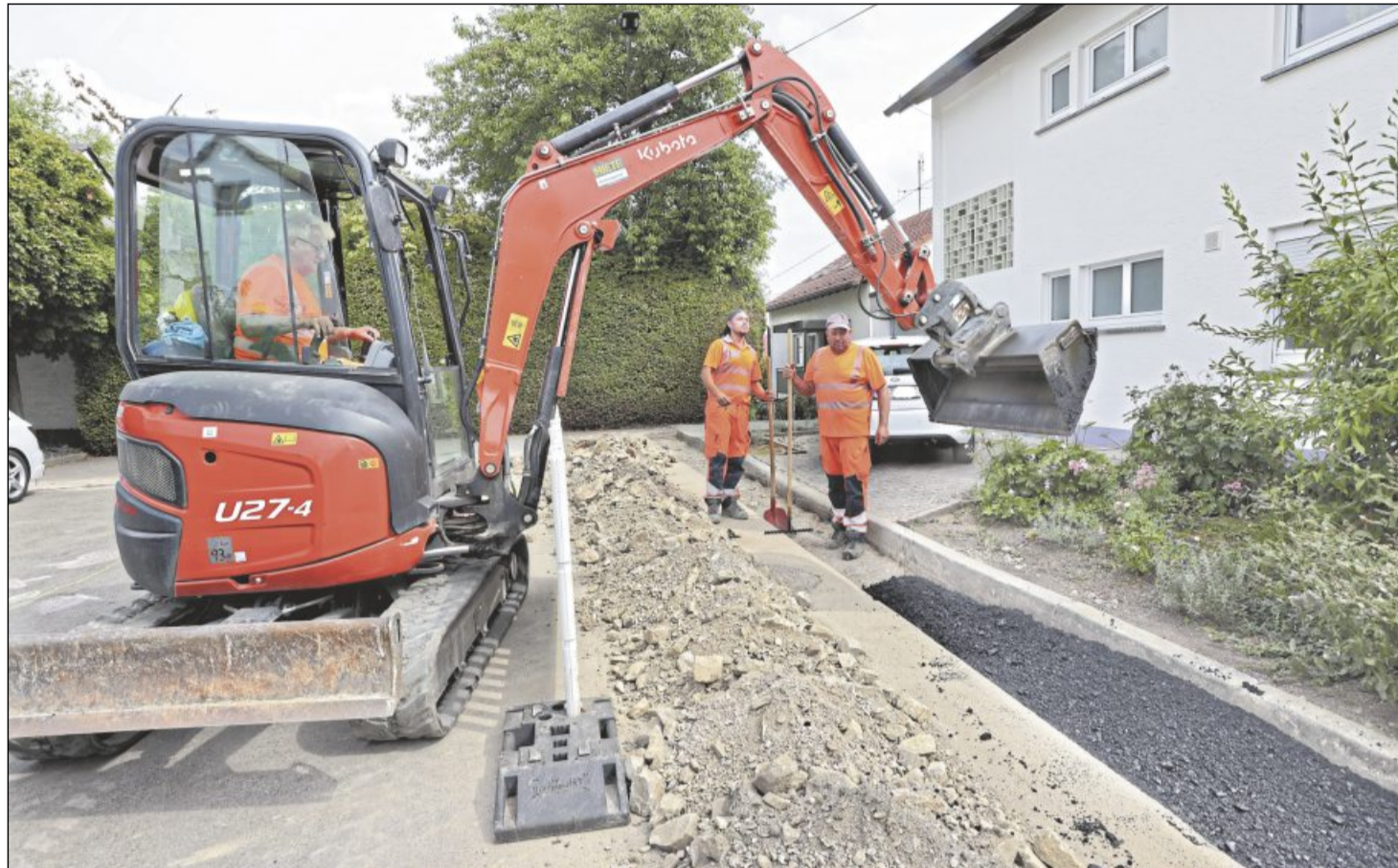
Im Auftrag von Wisotel sind die Arbeiter im Moment in Bittenfeld an der Ecke Schulstraße/Forchenstraße aktiv. Bislang wurden schon bei mehr als 100 Häusern Leerrohre verlegt, in die später Glasfaserkabel kommen – und die sorgen für eine schnellere Internet-Verbindung. Fotos: Schneider
